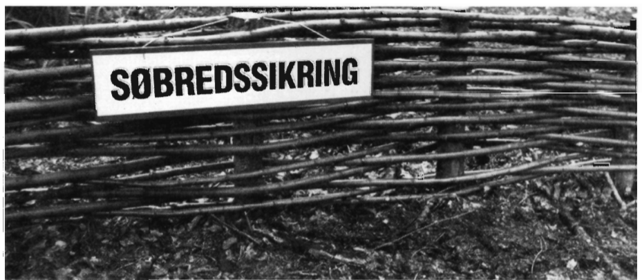
Figur 18. Pil brugt til sikring af søbredder. (Lydum energiplanter).
