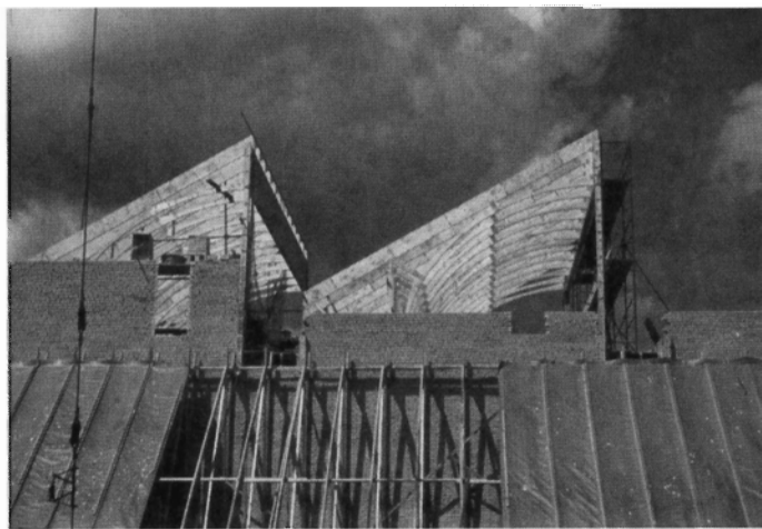
Figur 2. Sejs Kirke ved Silkeborg laves i høj grad med træ fra Palsgård. Spærene stammer fra spærfabrikken, og den udvendige beklædning er leveret af savværket.
