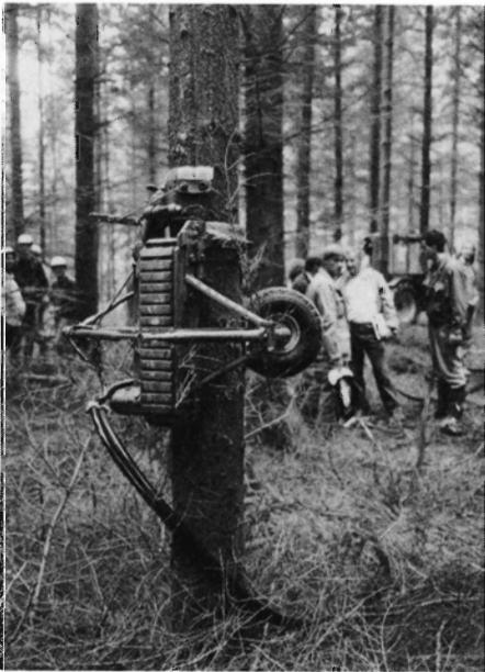
Figur 8. Et af de store tilløbsstykker var den tyske "Baumhexe", som drives hydraulisk fra en traktor.
