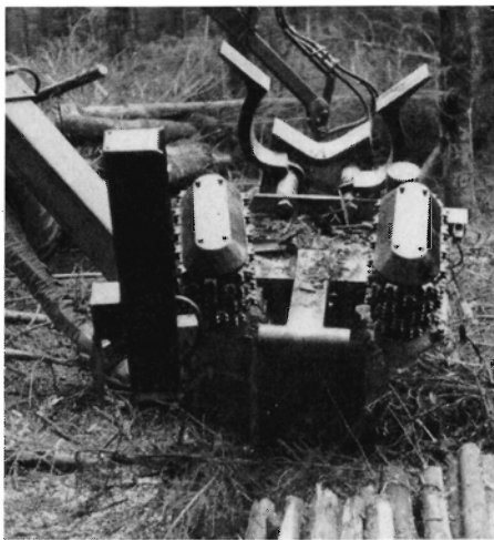
Fig. 13. Cetto MM 400/Gremo TT8 processor med dobbelt pigbælte til fremmadning af træet.
