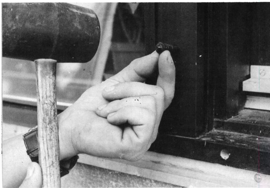
Fig. 1. Re-impregneringsventilen slås i.
