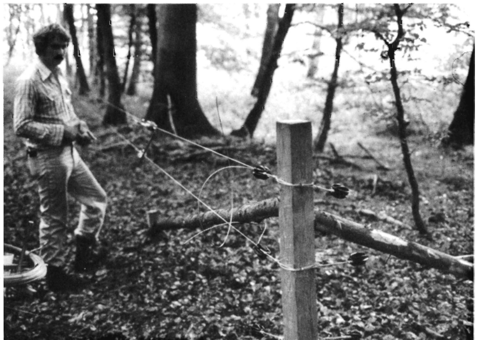
Fig. 2. Hjørnepæl isoleret med hjørneisolatorer. (Foto: P. Dalgaard).
